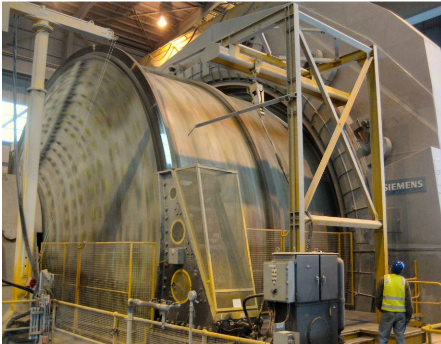
Von Siemens ausgerüstete 40-Fuß-SAG-Mühle bei Cadia Valley Operations
