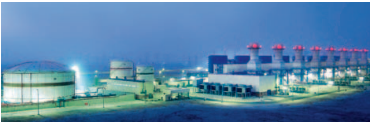
Mehr Power und weniger Emissionen: Siemens rüstet das Kraftwerk Az-Zour Süd zum GuD-Kraftwerk um
